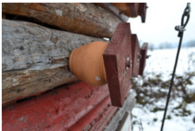
Kamrice za pikapolonice gre za lončene posode premera do 9 cm z lesenim pokrovom, ki ima 5 vhodnih luknjic premera 5 mm. Foto: Uroš Šonc
